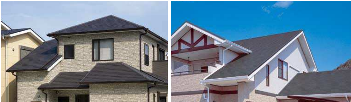
※施工写真はイメージです。
